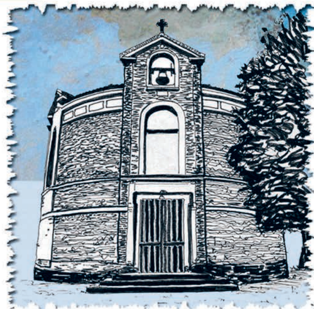
Ce bâtiment, fait de briquettes rouges, présente la particularité architecturale d'être construit sur plan circulaire.
