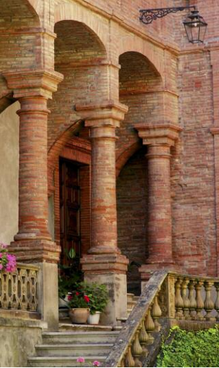
Detail of the Hôtel Mila de Cabarieu portico.
