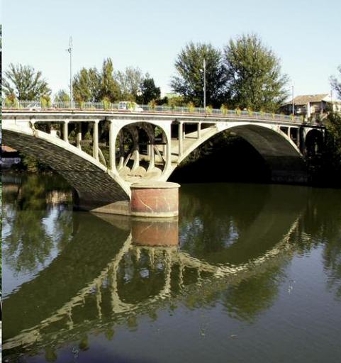
La articulación de los arcos en tres puntos y la utilización del hormigón armado permitieron la elaboración de un Puente Nuevo de enorme delicadeza cuya estructura presenta un ahuecamiento excepcional.
